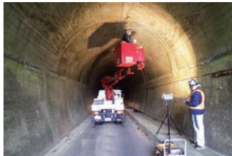
トンネル変状調査
