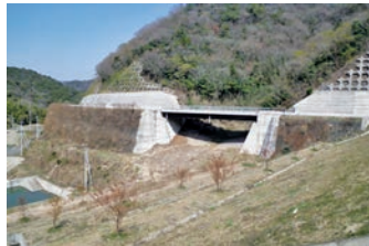
クリーンセンター搬入道路
