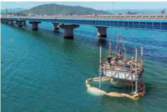
調査ボーリング(海上)
