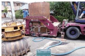
ケーシング建込工
