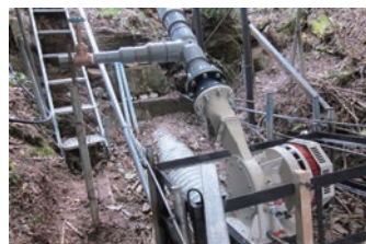
小水力発電 実証実験
