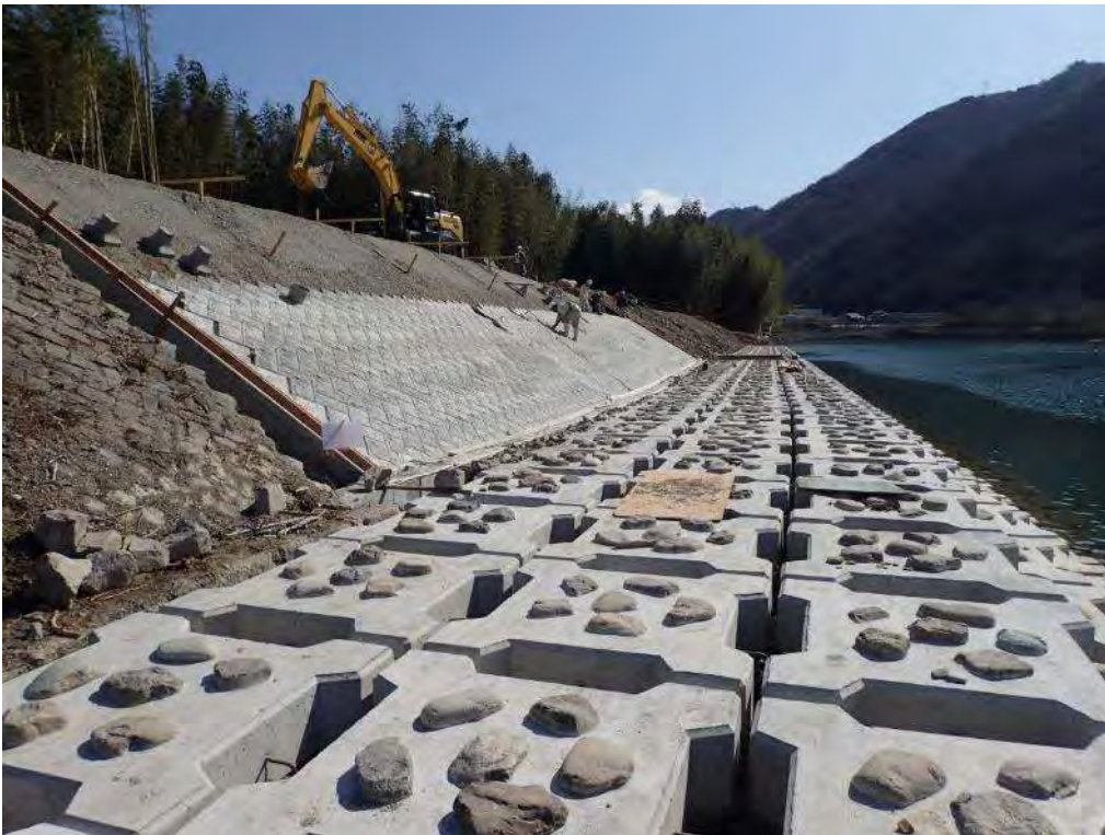
低水護岸工・根固め工
