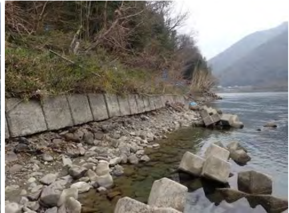
既存護岸の崩壊・河岸及び河床の洗掘
