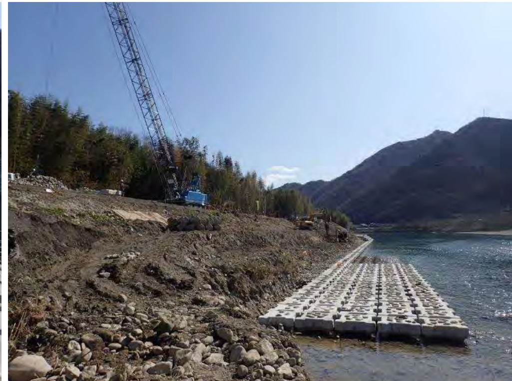
根固めブロック据付け
