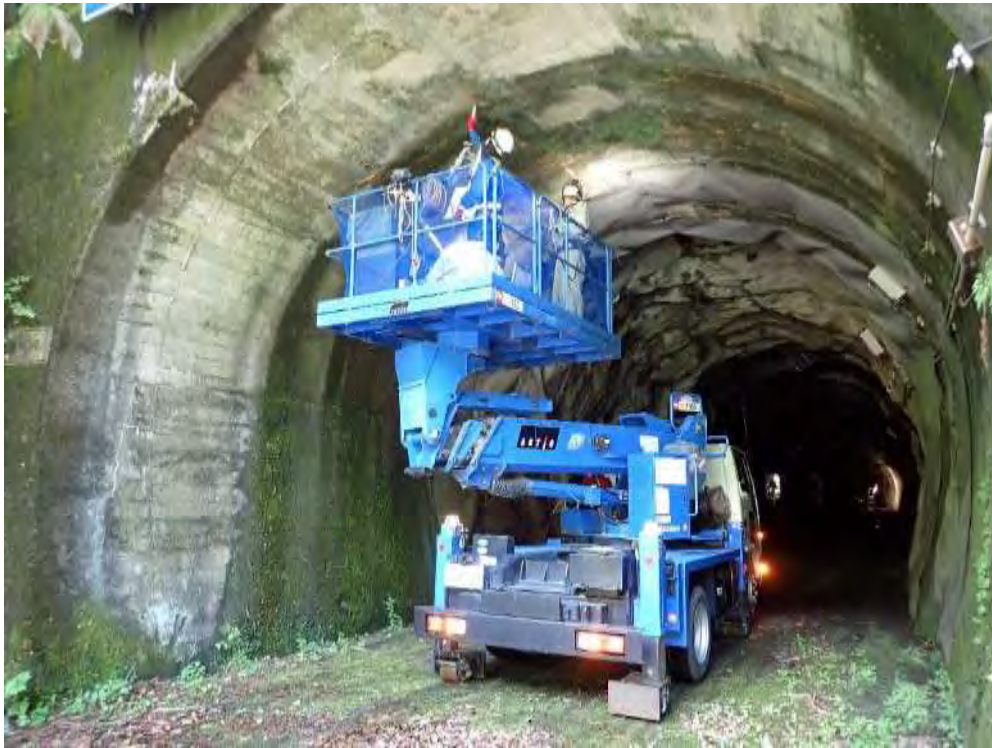
トンネル点検車
