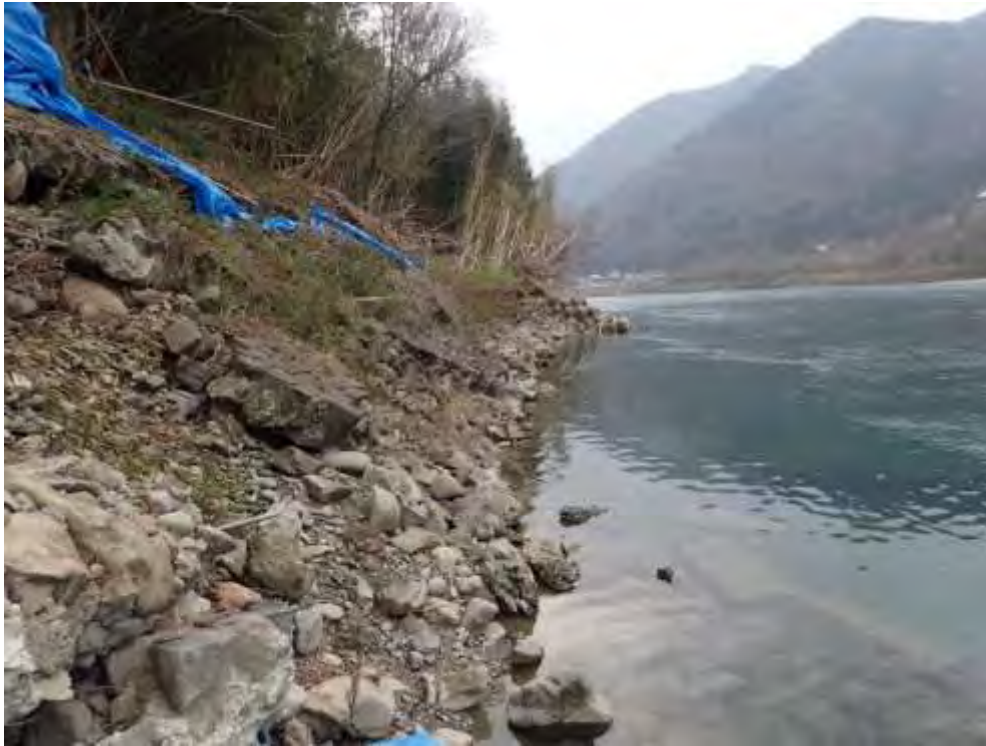
既存護岸の崩壊・河岸及び河床の洗掘
