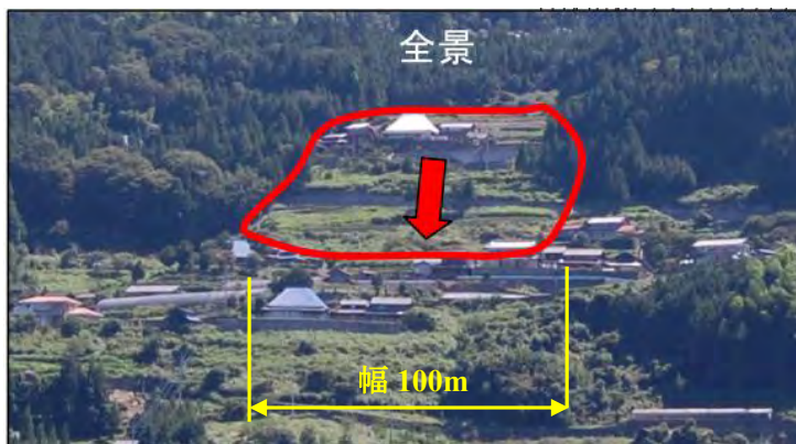
写真1 対象地すべりブロックの全景
