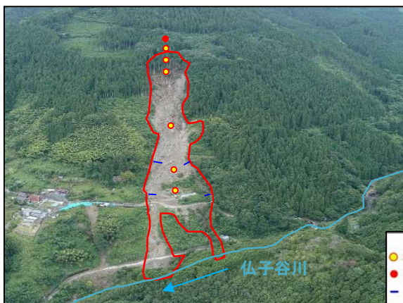
写真-1 災害発生後の斜面状況写真
