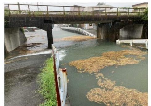
写真1 アンダーパスの冠水状況 (徳島新聞電子版 3) より引用)
